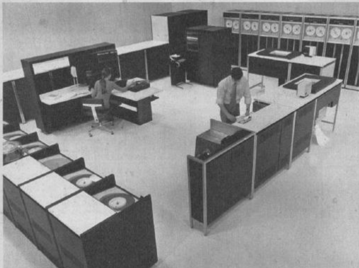
L'Honeywell Bull 2 000 comporte un ordinateur Datanet pour gérer toutes ses télécommunications.
